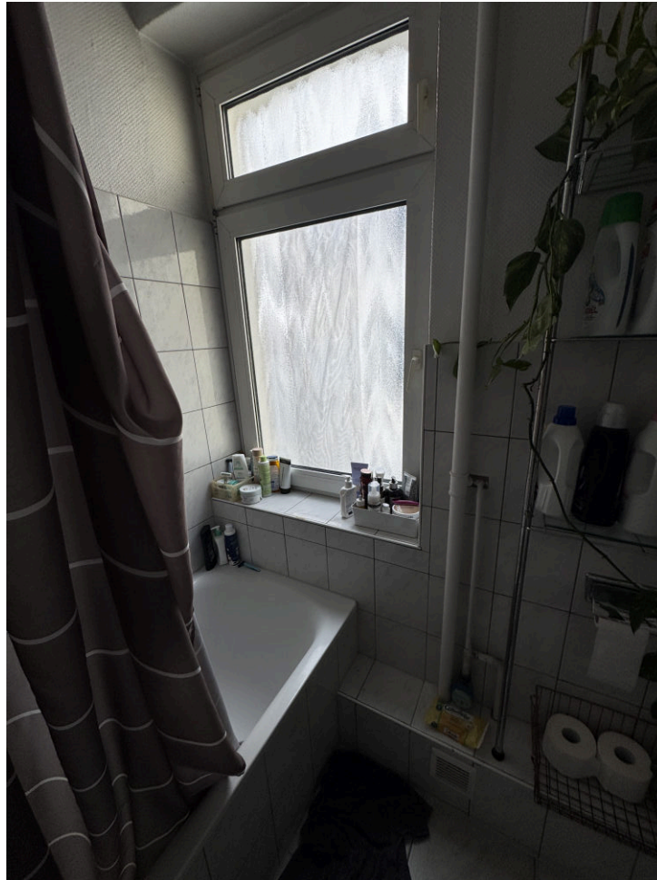
Beispiel Bad mit Badewanne unmittelbar am Fenster, Absturzsicherung in der Nutzung zu prüfen und gegebenenfalls nachzurüsten. Erstellt am 16.06.2026 um 16:56 Uhr.
